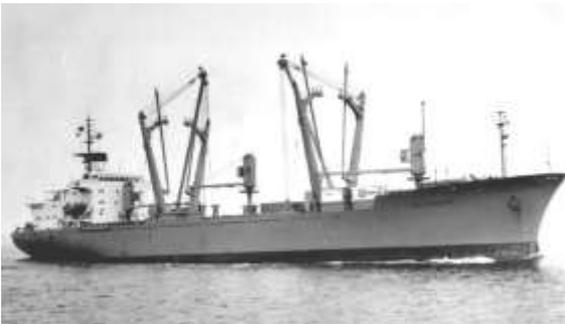
1970 bei den Lübecker Flender-Werken für die DDG „Hansa“ in Bremen gebaut, kann man dieses Schiff als multifunktionell betrachten. Die GOLDENFELS ist 153,27 m lang, 22,80 m breit und hat einen Tiefgang von 10,06 m. Mit einer Dienstgeschwindigkeit von 19,2 kn konnte man es als Schnellfrachter ansehen. Vermessen mit 10.549,99 BRT, 6.855,28 NRT konnte es 718.308 cbf Stückgut fassen bei einer Tragfähigkeit von 14.400 tons. Geeignet
